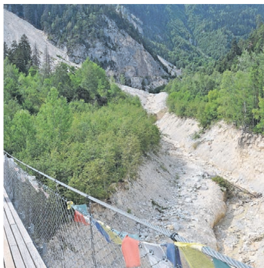
Die Bhutanbrücke wird saniert.
