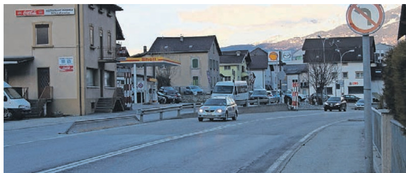
Susten: Mit einem Provisorium ist die Gefahrensituation vorerst entschärft.
