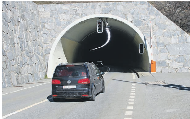
Mittaltunnel: Dringende Sanierungen sollen die Durchfahrt sicherer machen.
