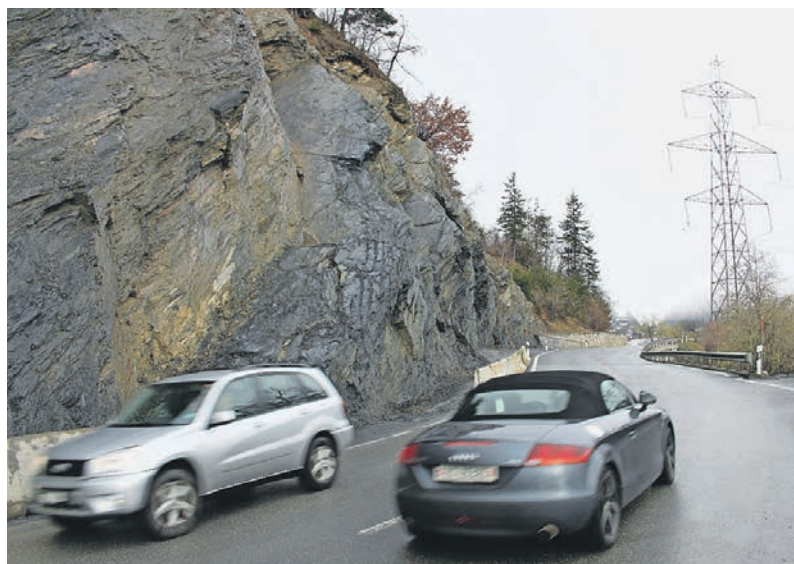
Die Felssturzgefahr zwischen Rumeling und Inden ist weiterhin gegeben.
